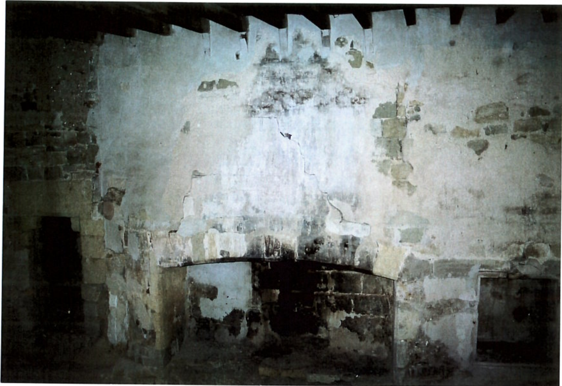
Fig. 60 : MUR EST DE LA SALLE
