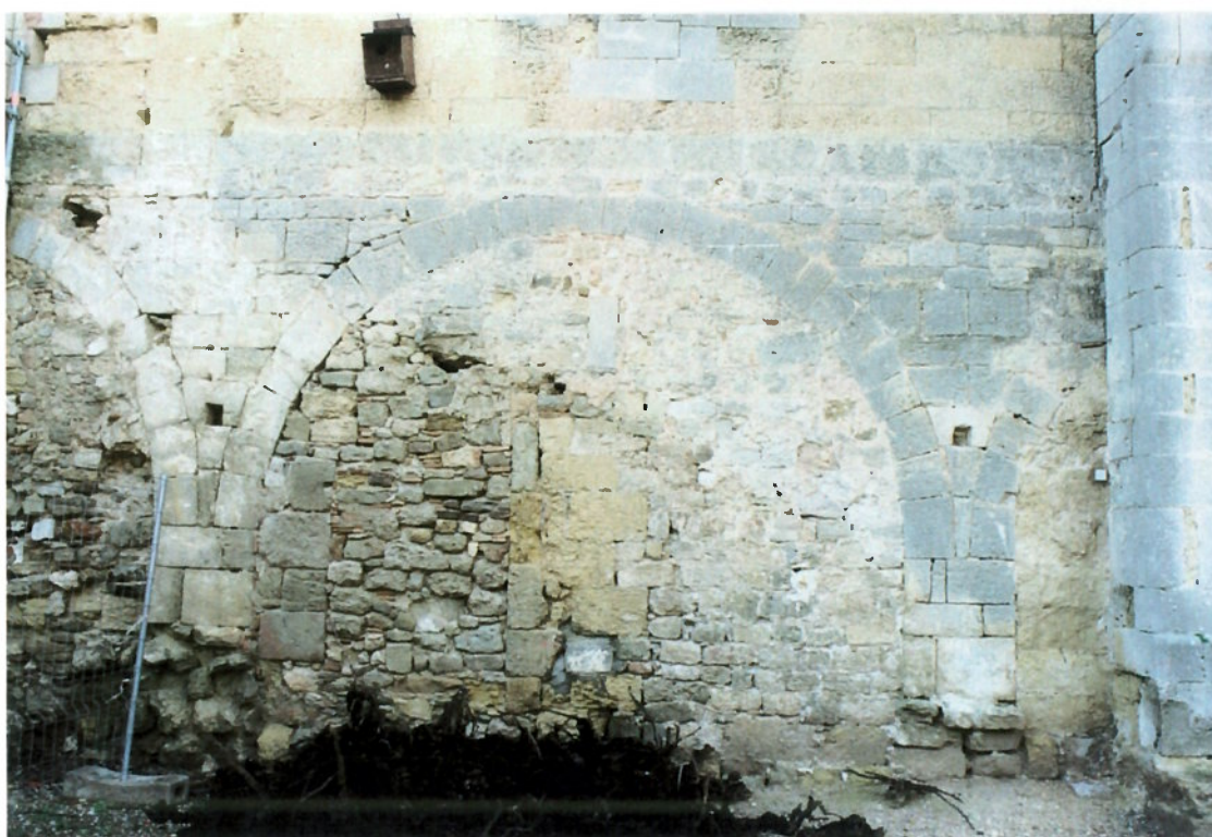
Fig. 32 : ARCADE 18 007 DU REZ-DE-CHAUSSEE
