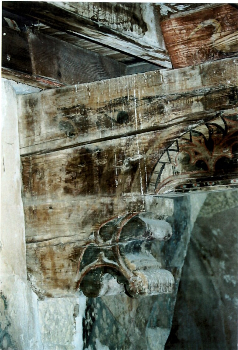
Fig. 118 : ABOUT D'UNE POUTRE ET SON CORBEAU
