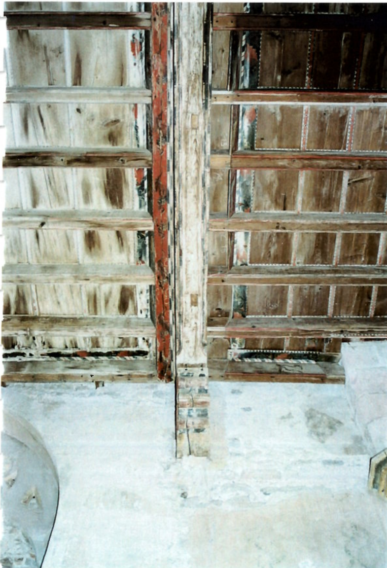
Fig. 129 : SOUS FACE DE LA POUTRE 2 : CAVITES D'ANCRAGE D'UNE CLOISON cliché : A. Marin, Hadès, 2004
