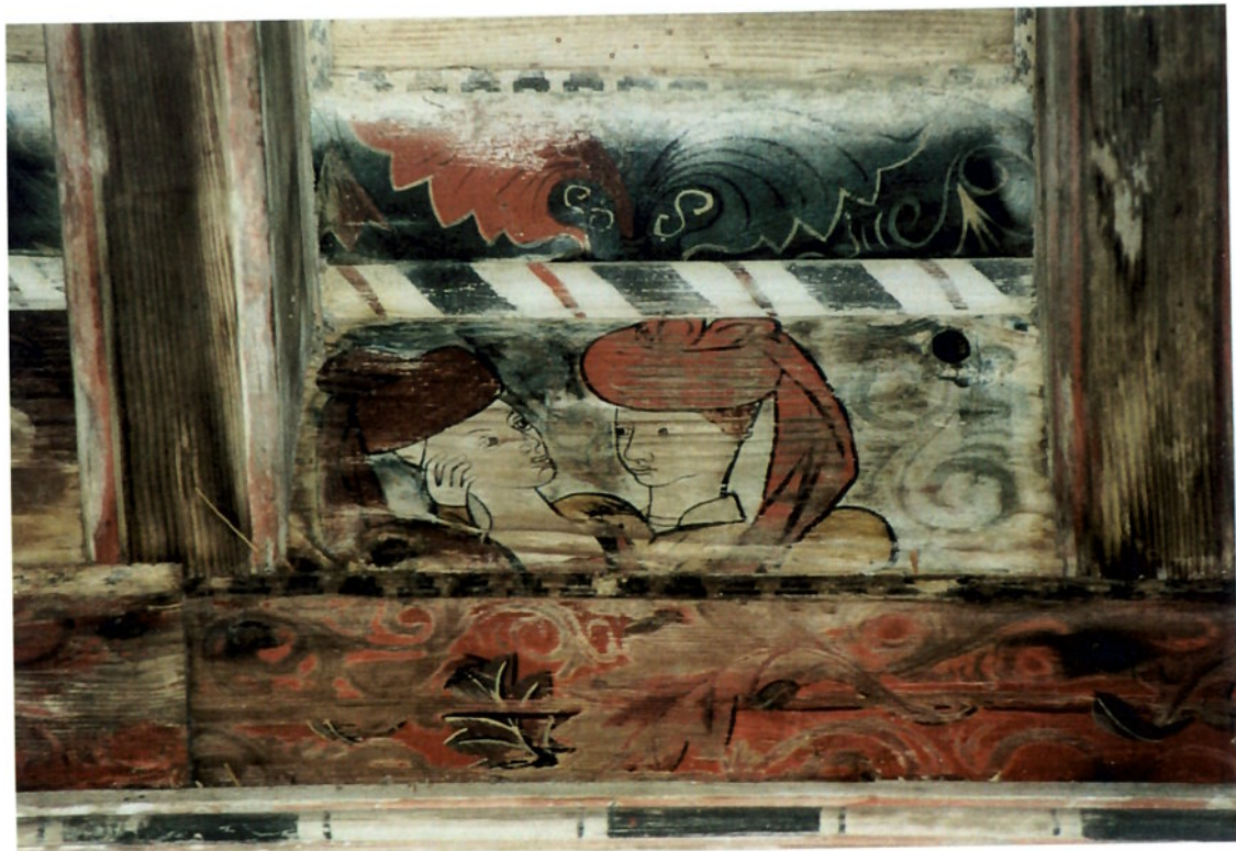
Fig. 127 : COUPLE SUR UN PAREDAL DE LA POUTRE 2
