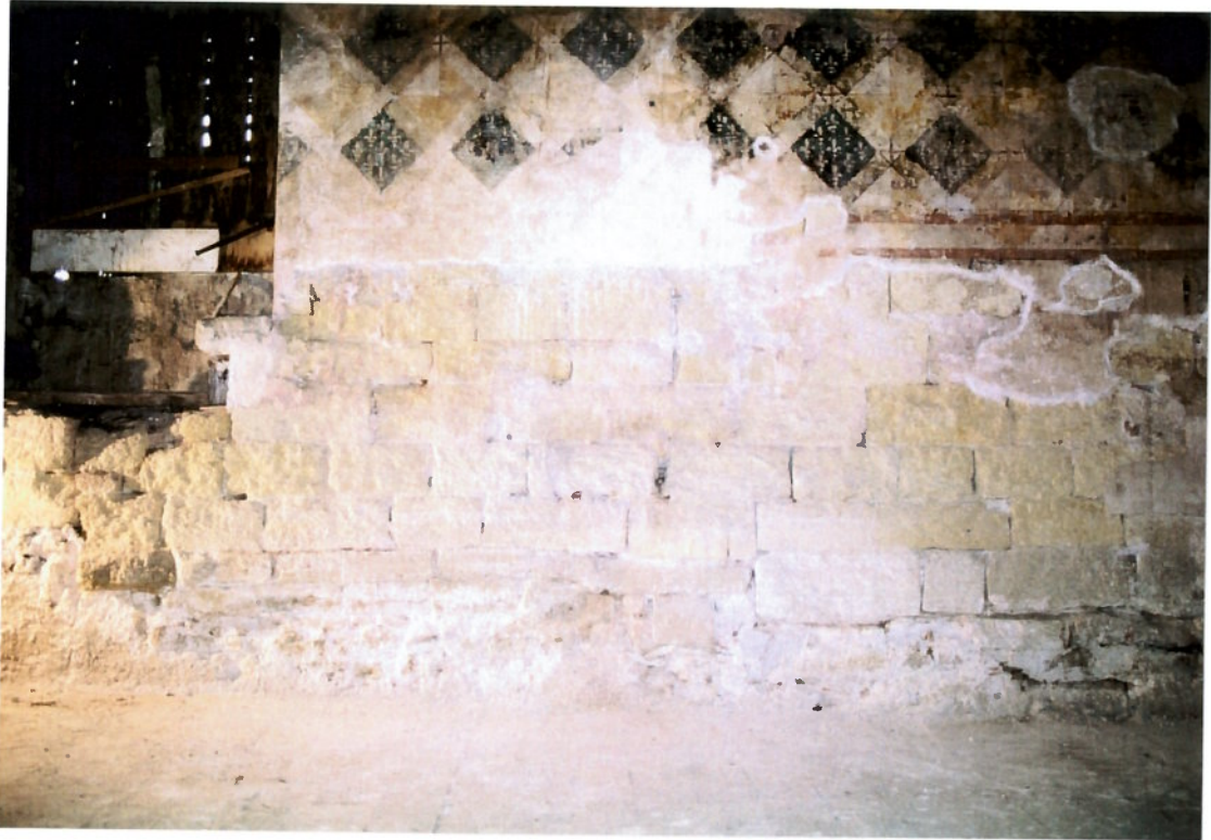
Fig. 37 : SOUBASSEMENT DU MUR SUD , 1er ETAGE DU LOGIS 2
