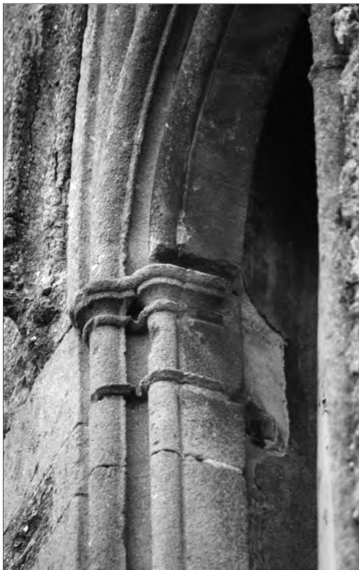
FIG. 22. LA FAÇADE NORD, FENÊTRE OUEST. Détail des faux chapiteaux du montant de gauche. Cliché Agnès Marin.
