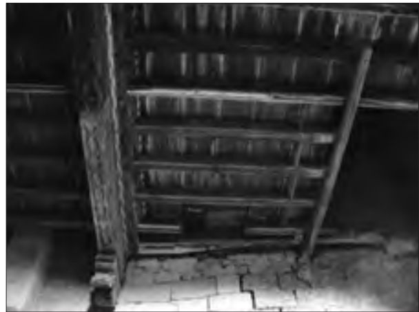
FIG. 35. LE PLAFOND, POUTRE 1. Trace de la cloison longeant une solive pour isoler un espace de dégagement, et parédals marquant l'emplacement du chevêtre d'un escalier d'accès aux combles. Cliché Agnès Marin.
