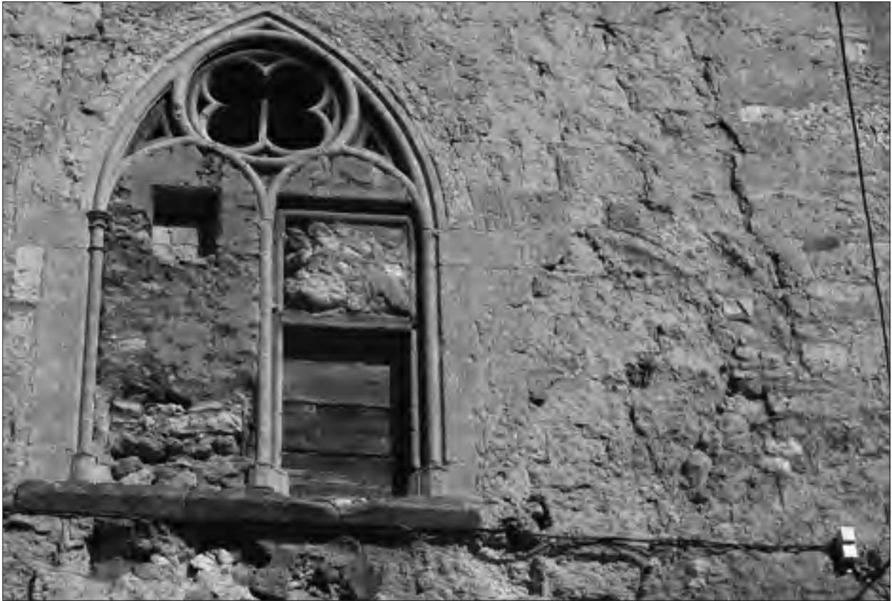
FIG. 36. LA TOUR-SALLE, FAÇADE SUD. Fenêtre à remplage de la fin du XIII e siècle transformée en demi-croisée au XV e siècle. À droite, trace de l'arc de la baie d'origine. Cliché Agnès Marin.
