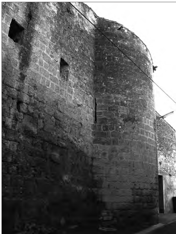
FIG. 21. LE FRONT NORD DE L'ENCEINTE. Tour d'angle nord-ouest et son unique archère. Cliché Agnès Marin.
