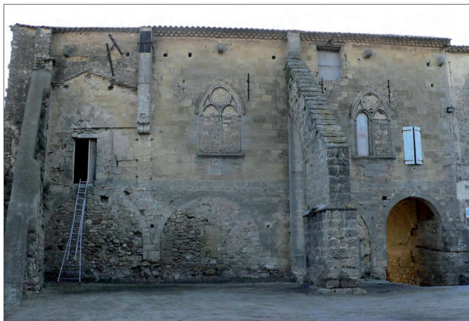
FIG. 7. LA TOUR DEPUIS LA COUR. Façade nord. Cliché Agnès Marin.
