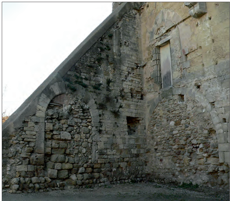
FIG. 6. VUE DE L'ANGLE SUD-EST DE LA COUR. Ruine de la construction initiale contre laquelle s'appuie le bâtiment de la phase 2. Cliché Agnès Marin.
