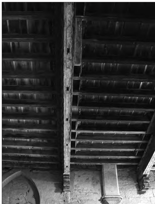
FIG. 34. LE PLAFOND, POUTRE 2. Mortaises entaillées dans la face inférieure de la poutre pour le maintien d'une cloison. Cliché Agnès Marin.
