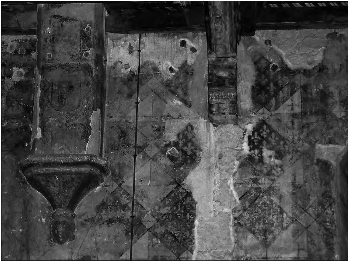
FIG. 23. LA SALLE DE L'ÉTAGE, MUR SUD. Cul de lampe de l'arc diaphragme et décor peint du début du XIV e siècle. Cliché Agnès Marin.
