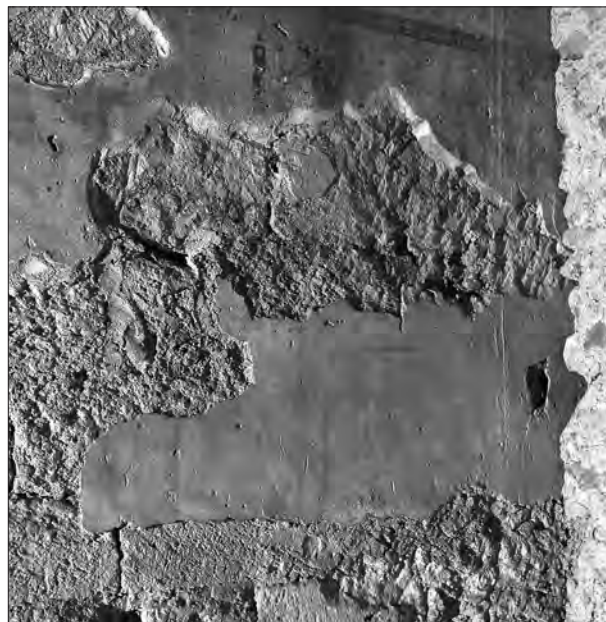
FIG. 18. LA SALLE DE L'ÉTAGE, PAROI SUD. Plaque d'enduit peint antérieure au décor du XIV e siècle, bûché en haut à droite du cliché. Cliché Diane Joy.
