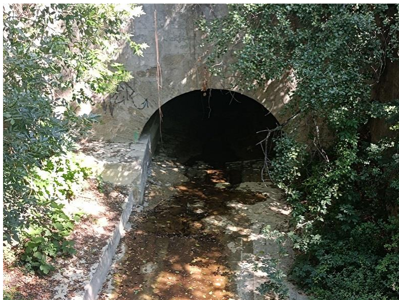
l'aqueduc de Saïsses
