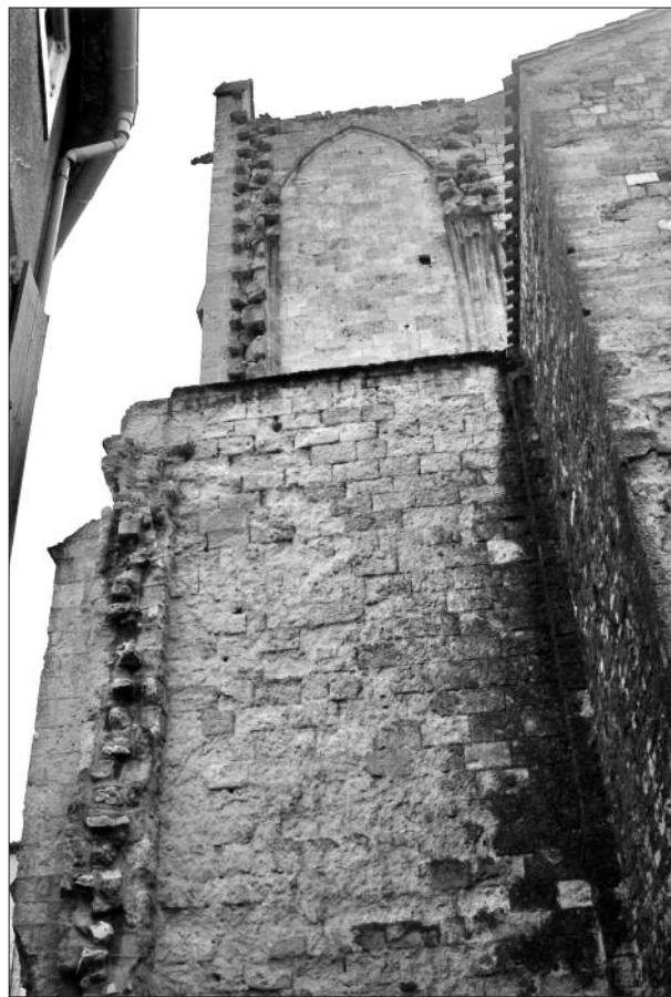
FIG. 18. CHAPELLE NORD, VUE DU MUR DE RETOUR. Pierres d'attente et liaison avec l'élévation nord de la première travée. Cliché A. Béa.
