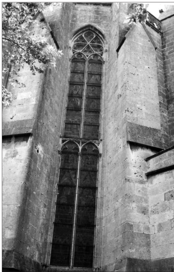
FIG. 9. CHEVET. Détail d'une fenêtre. Cliché A. Béa.
