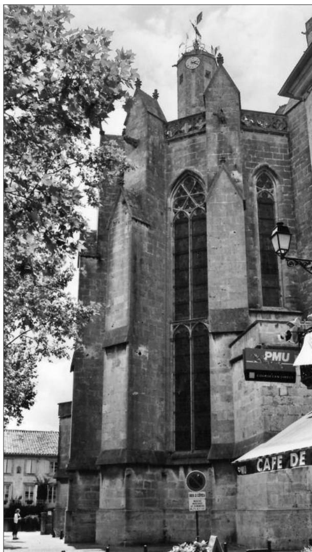
FIG. 7. VUE NORD DU CHEVET. Cliché A. Béa.
