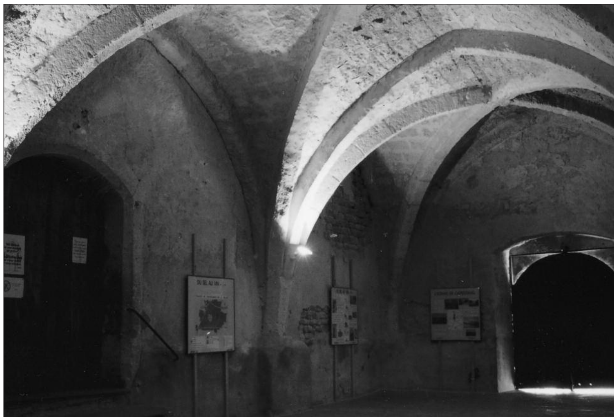
FIG. 6. VUE INTÉRIEURE DU PORCHE. Cliché A. Béa.
