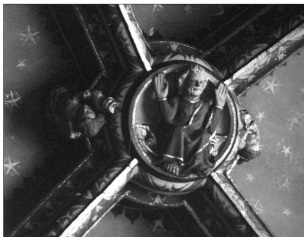
FIG. 15. CLEF DE VOÛTE DE LA DEUXIÈME CHAPELLE SUD. Cliché A. Béa.
