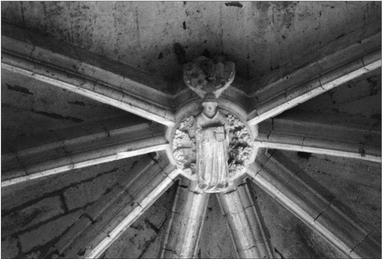
FIG. 10. VUE DE LA CLEF DE VOÛTE DE L'ABSIDE. Cliché A. Béa.
