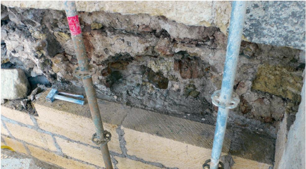
consolidation des matériaux actuellement utilisées par le Service des monuments historiques semblent inadaptées au vu du degré très important d'altération des matériaux.
