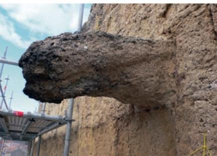
Vestiges d'une gargouille avant dépose, façade sud.
