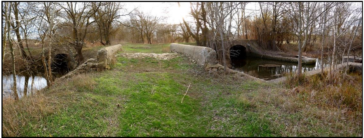
la Via Domitia, au niveau de Pontserme
